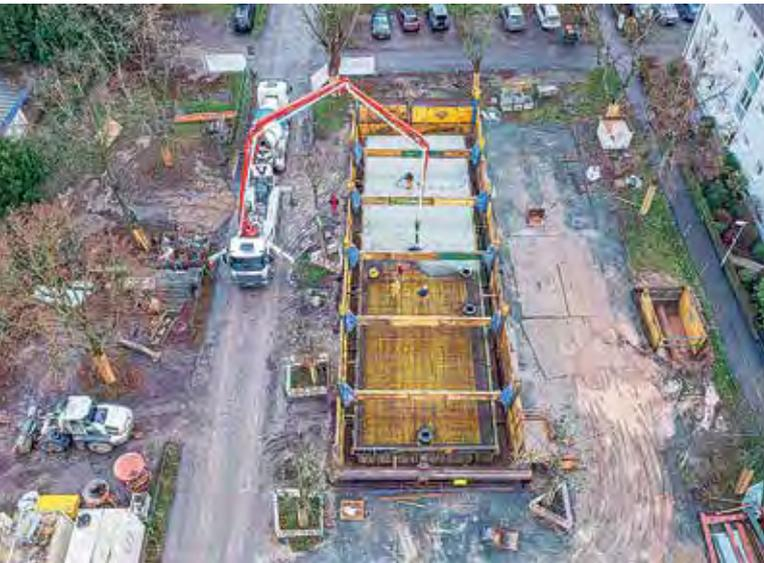
Von oben werden die Dimensionen des neuen Regenrückhaltebeckens (zu sehen ist das Betonieren der Decke) deutlich sichtbar. Foto: Sonntag Bau
