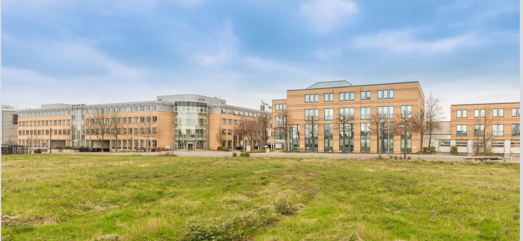
Außenansicht – Monzastraße 2 (links) und Monzastraße 4 (rechts)
