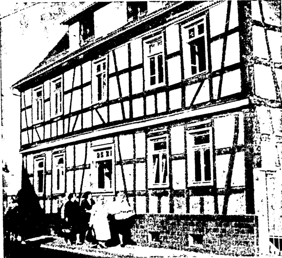
Ist dieses alte Fachwerkhaus in der Frankfurter Straße zum Abbruch reif? Die Passanten wundern sich, daß es leer steht und die Fensterscheiben eingeworfen sind.
