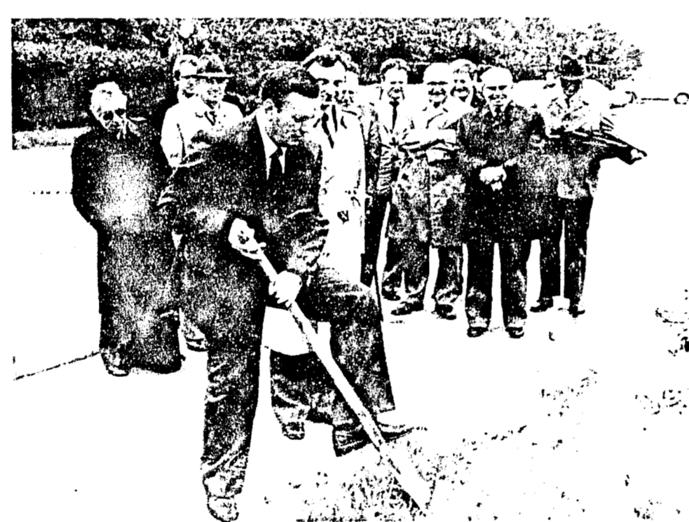
Bürgermeister Hans Dürner beim ersten Spatenstich für 26 Sozialwohnungen der Gemeinnützigen Baugenossenschaft Langen, die in der Leipziger Straße errichtet werden.
