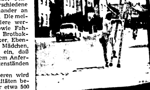
Trutz Sommerhitze arbeiten Handwerker fleißig daran, die Farbe der Straßenleuchten in der Süd, Ringstraße zu erneuern.
