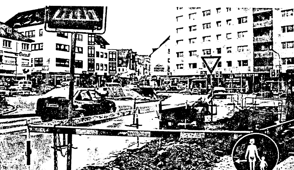
Am Lutherplatz gehen die Umbauarbeiten unvermindert weiter. Dabei können sich die Verkehrsteilnehmer bereits daran gewöhnen, wie sie später in gedroseltem Tempo diesen Mittelpunkt Langens durchfahren müssen. Foto: rt
