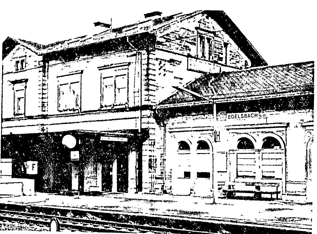
Der Abriss des Bahnhofsgebäudes scheint beschlossene Sache zu sein. Vom 13. bis zum 27. März soll Egelsbach in diesem Jahr die Gemeinde - bei ihrer ursprünglichen Konzeption geblieben, das Gebäude abzubrechen. Nach Angaben der DB ist bei einem Erhalt des Bahnhofs der Trennenverlauf geändert worden. Dadurch würden aber zusätzliche Kosten entstehen. Vom 13. März an läuft eine vierwöchige Einspruchsfrist gegen den Planfeststellungsbescheid.
