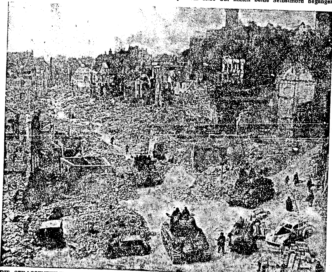
DIE STRASSENZEILEN SIND VERWISCHT, durch die Trümmer führen Trampelpfade. — Nürnberg, Ende April 1945, nach der Einnahme durch amerikanische Truppen. In allen deutschen Großstädten das gleiche traurige Bild: Ruinen, Schutt und Asche. Für die Menschen ist der Leidensweg noch nicht zu Ende. Es besteht Seuchengefahr, es fehlt an Medikamenten. Noch viele sterben an den Folgen eines sinnlosen Krieges.
