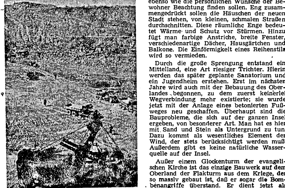
Lastwagen, Bagger und Kräne bestimmen das Bild. Hier ein Ausschnitt von den Planierungsarbeiten auf dem Unterland der Insel.
