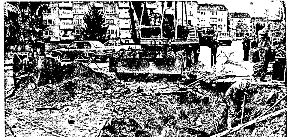
Mit dem Bagger, aber vor allem mit Schaufeln, wurde das Leck in der Hauptwasserleitung freigelegt. Die Arbeiten gestalteten sich etwas zeitraubend, weil man auf andere Versorgungsleitungen achten mußte, die nicht beschädigt werden durften.
