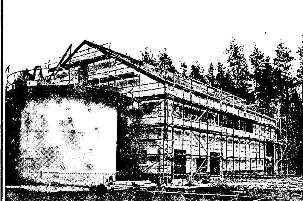
Die neue Halle für die Klärschlamm-trocknung in der Verbandskläranlage Langen/Egelsbach/Erzhäusen ist im Rohbau fertig. In nur vier Monaten wurde das Bauwerk errichtet. Jetzt kommt das wesentlich teurere „Innenleben“ dran.
