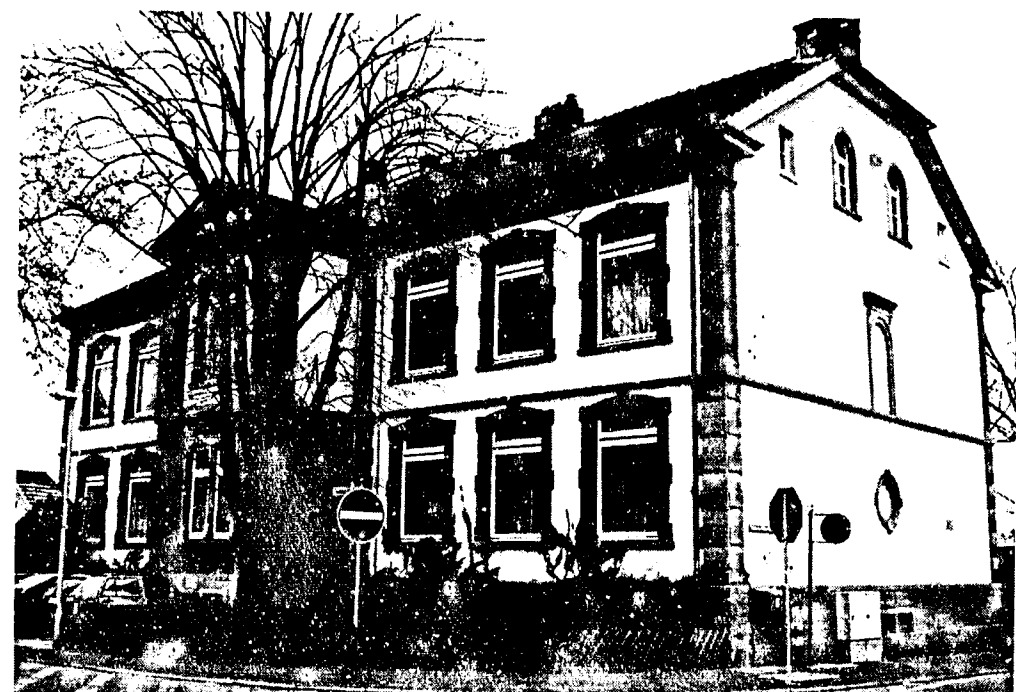
Für 1,4 Millionen Mark wird die Schule am Weiher im nächsten Jahr umgebaut, ehe die Mitarbeiter des städtischen Baudezernats einziehen können.
