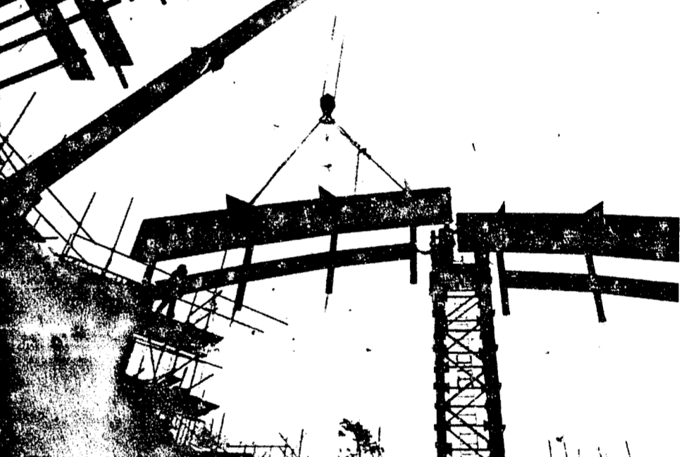
Als wahre Artisten erwiesen sich Kranführer und Handwerker am Dienstagvormittag an der Baustelle der neuen Albertus-Magnus-Kirche, als die Hauptträger für die Dachkonstruktion angebracht wurden. Zwei Stahlkransträger von jeweils 13 Tonnen Gewicht wurden millimetergenau in ihre Verankerungen gesetzt. An ihnen werden – vermutlich in der kommenden Woche – die Leimbinder befestigt, die zusammen eine selbsttragende Dachkonstruktion ergeben.
