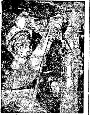
Ein eindrucksvolles Bild von der Arbeit unter Tage gelang unserem Fotografen beim Ausbau der Schachtanlage „Hugo“ in Gelsenkirchen. Ein Bergmann setzt hier in der Untertageanlage einen hydraulischen Stempel ein.
