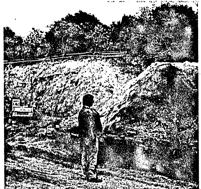
Von einer ursprünglichen Filchengröße in Höhe von 22 000 Quadratmetern ist bei dem neuen Baugebiet am Steinberg die Rede.
