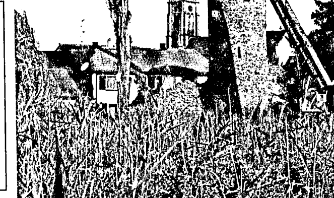
Stück für Stück wird die Pappel von oben abgesägt. Der Blitz hatte ein unheilvolles Werk verrichtet und die Standfestigkeit des Baumes gefährdet. Diese Pappel wurde im Jahre 1953 gepflanzt, auch damals bereits als Ersatz für eine vorher vorhandene. Eigentlich gehört eine Pappel zum gewohnten Bild. Wie zu hören war, soll jetzt eine Säulen-Halbhuhe gepflanzt werden. So hält man bei uns auf Tradition. Foto: r
