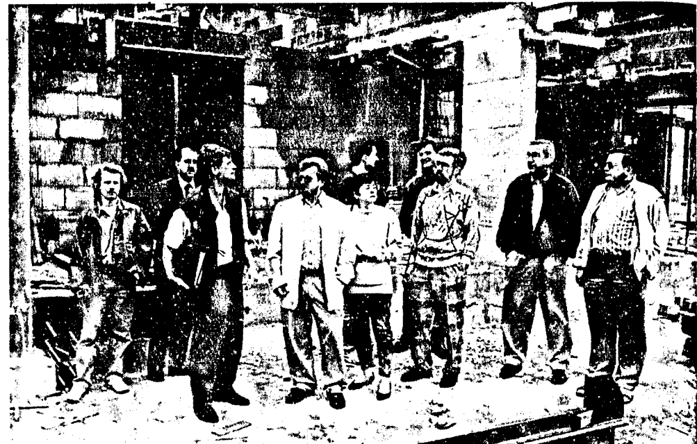
Mitglieder von SPD Vorstand und Fraktion informieren sich über den Fortgang der Bauarbeiten am Jugendzentrum. Foto: P.
