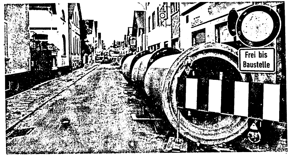
Bilder wie dieses gab es im Jahre 1988 in Langen viele. Es waren zwölf Monate der Straßensperren und Straßenbauarbeiten, die nicht nur den Autofahrern zu schaffen machten.
