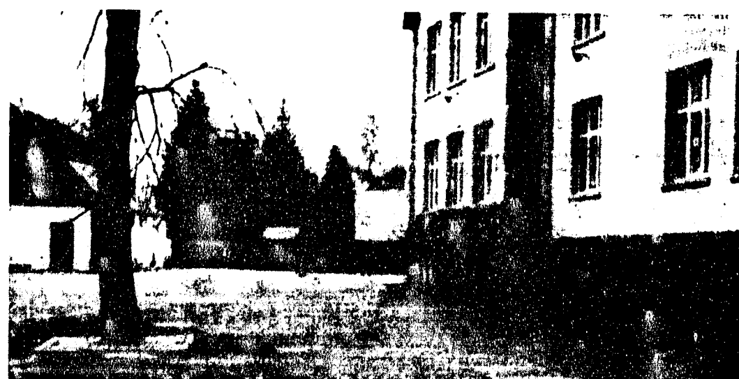
Der Hof der Walschule ist in einem sehr desolaten Zustand. Noch in diesem Jahr soll er saniert werden.
