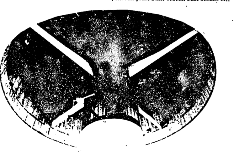
zentrale Nahe mit den vier Windblättern als Turbine und dem Generator in der Mitte zu sehen. Aus dem umgebenden Zeit strömt warme Luft in den Kamin und bewegt die Turbine.
