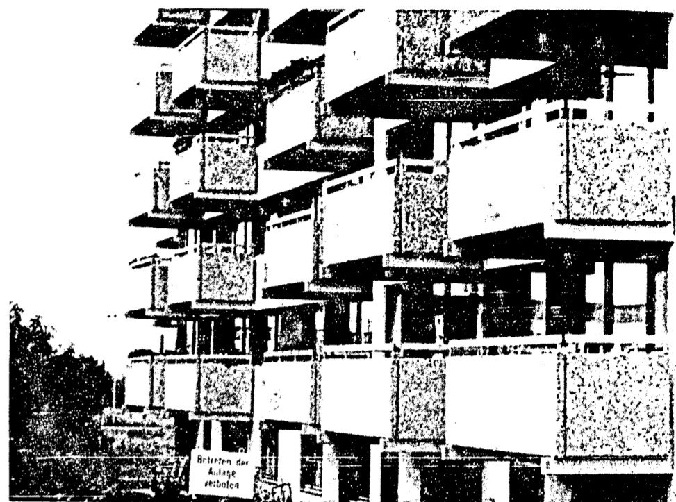
„Balkonen“ im Wohngebiet Bayerseich. Da hilft nur eine individuelle Begrünung durch die Bewohner.
