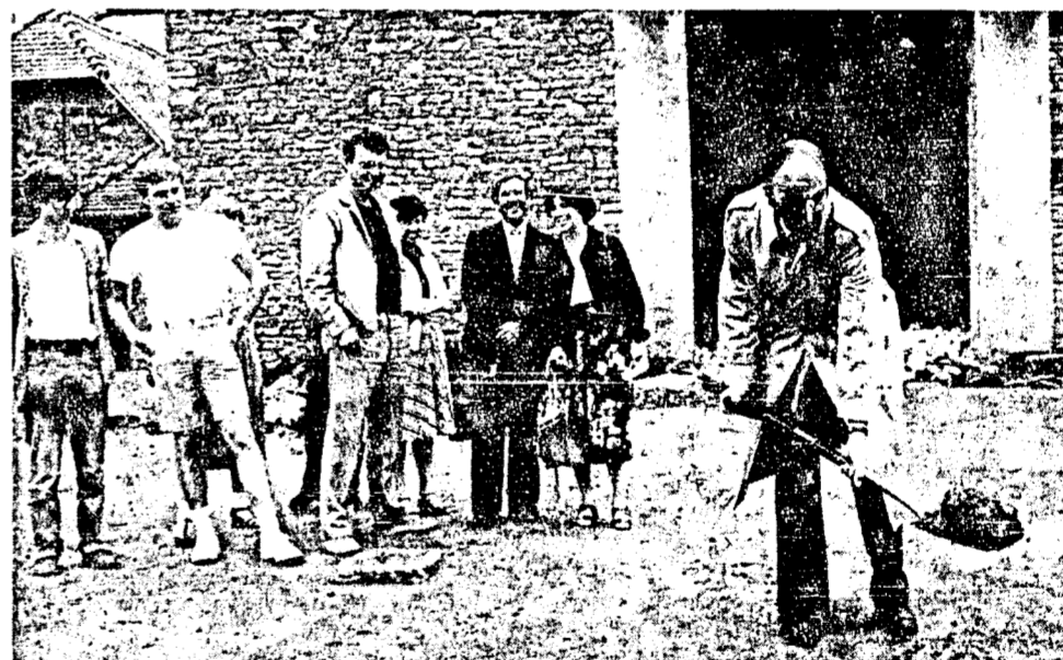
Erster Stadtrat Klaus Vetzberger nimmt den ersten Spatenstich zum Um- und Ausbau der Winkelsmühle vor.
