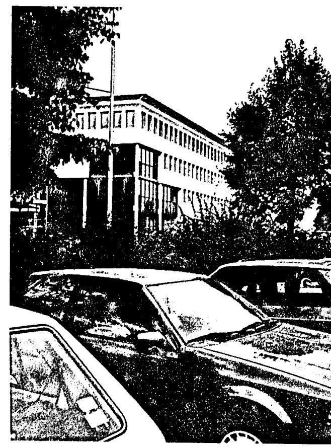
Ein neues Gebäude hilft das Langener Stadtbild prägen. Am Neubau des Finanzamtes in der Zimmerstraße verschwand das Gerüst. Bis zur Inbetriebnahme wird es noch eine Weile dauern, denn nun kommen noch die Innenarbeiten an die Reihe.
