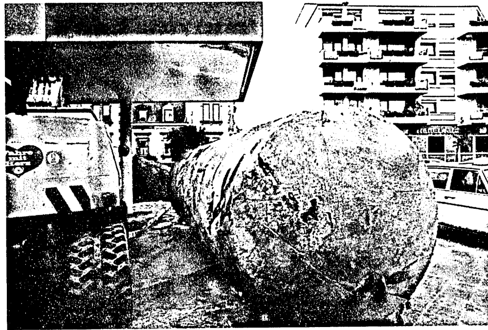
Nun gibt es auf der Bahnstraße keine Tankstelle mehr. Nachdem bereits im Jahre 1984 im oberen Teil der Straße die Zapfsäulen demontiert wurden, erlitt jetzt die Tankstelle gegenüber der Romanin-Anlage das gleiche Schicksal. Zwei riesige Tanks - der eine faßt 21 000, der andere 25 000 Liter - wurden aus dem Erdreich gezogen. Nach Angaben von Rathaussprecher Alex Lewitzki waren die einstmals mit Treibstoff gefüllten Tanks dicht. Jedenfalls habe der Umweltbeauftragte der Stadt, Siegmund Krüger, weder eine Verfarbung des Erdreichs noch „einschlägige Gerüche“ ausmachen können.
