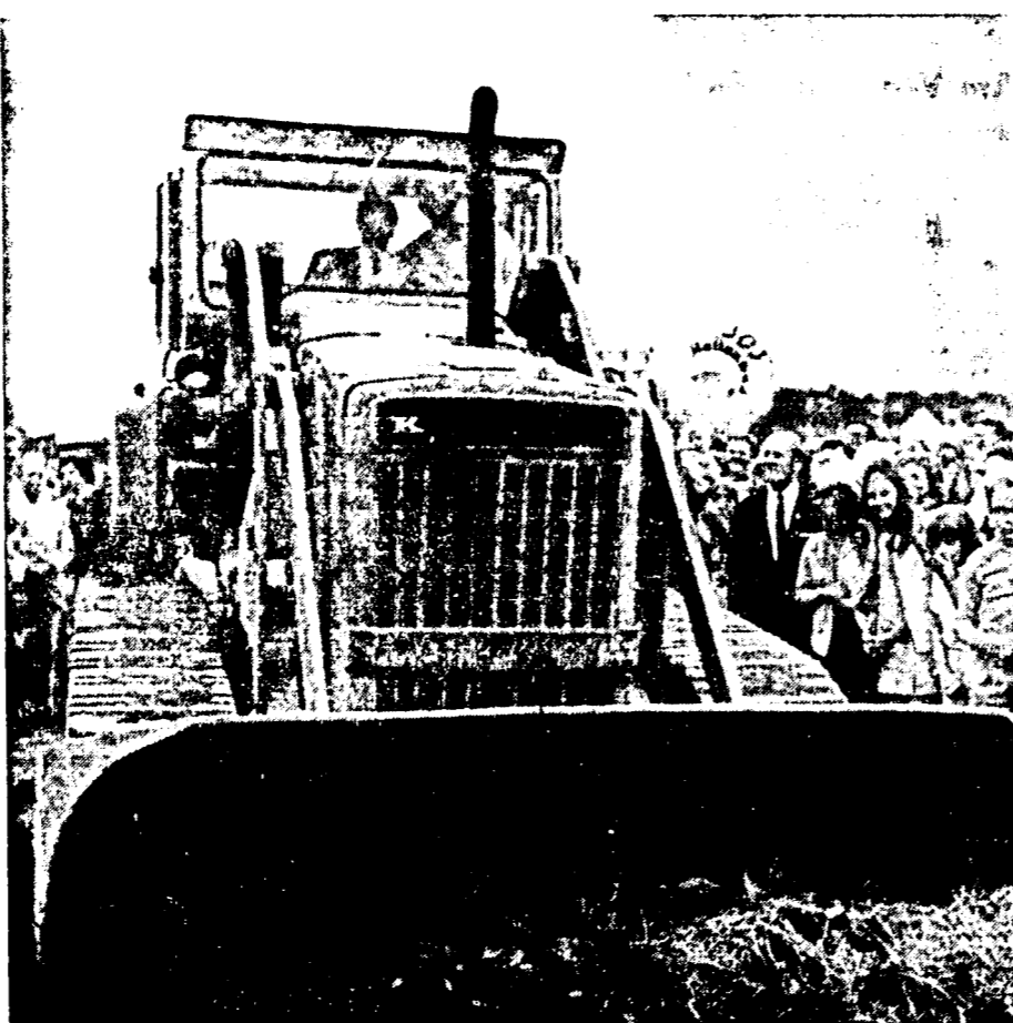
Zum ersten Spatenstich Hallenbad
