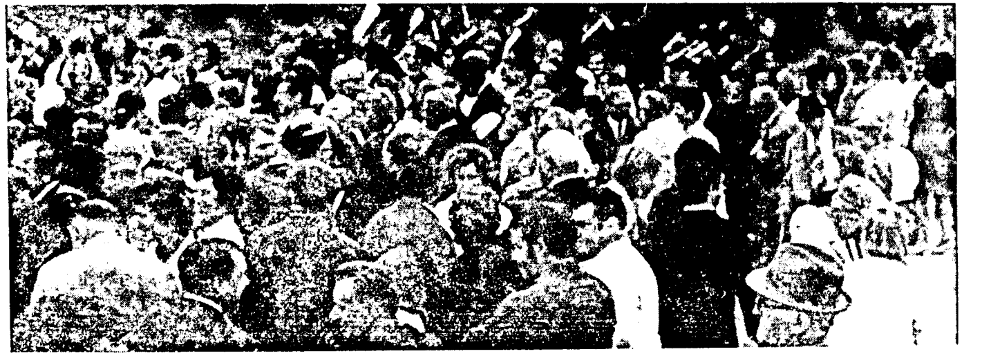
Die Bevölkerung nahm am ersten Spatenstich regen Anteil.
