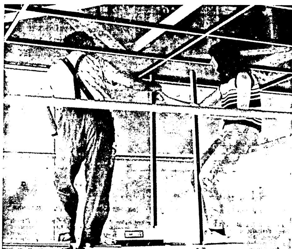
„Schularbeiten“ während der Ferien: Handwerker mit freiwilliger Hilfe in der Albert-Einstein-Schule.
