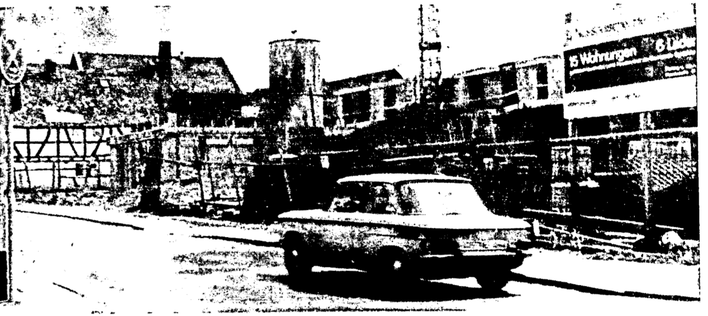
Blick auf das Baugebiet des ersten Sanierungsabschnitts, Ecke Ernst-Ludwig-Str./Kirchstr. mit 15 Wohnungen und sechs Läden. EN-Bild
