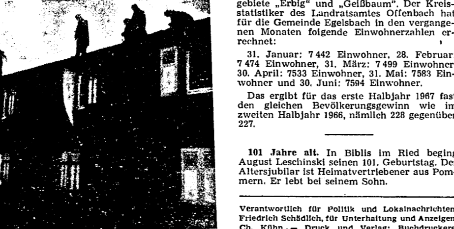
Großer Schaden entstand an einem Wohnhaus in der Heinestraße, wo der Sturm das Dach weggerissen hatte. Das Regenwasser drang in die Wohnung ein. Mit Dachpappe und Laten füllte die Feuerwehr den Innenraum ab. Ein großer Schaden, um größere Schäden zu verhindern.
