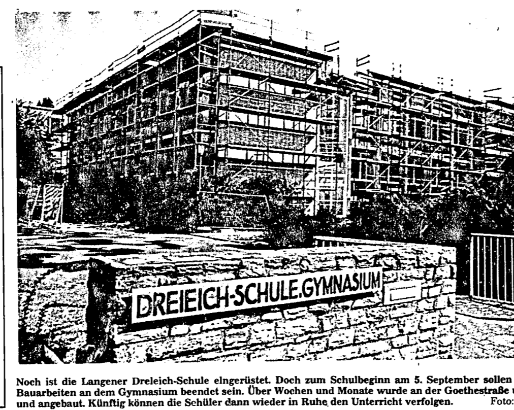
Noch ist die Langener Dreieich-Schule eingerüstet. Doch zum Schulbeginn am 5. September sollen die Bauarbeiten am Gymnasium beendet sein.
