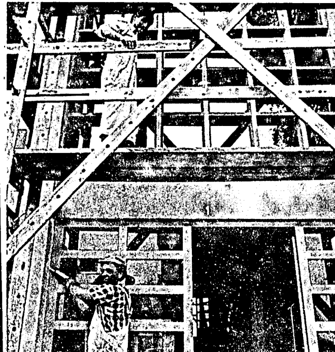
Das Hessische Flüchtlingswohnheim an der Straße der Deutschen Einheit wird renoviert. Der erste von drei Blocks soll im Oktober wieder bezugsfertig sein. Foto: sor
