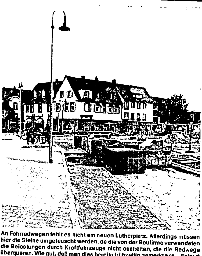
An Fahrradweg fehlt es nicht am neuen Lutherplatz. Allerdings müssen hier die Steine umgetauscht werden, da die von der Beufirma verwendeten die Belastungen durch Kraftfahrzeuge nicht aushielten, die die Redwege überqueren. Wie gut, daß man dies bereits frühzeitig gemerkt hat. Foto: tr
