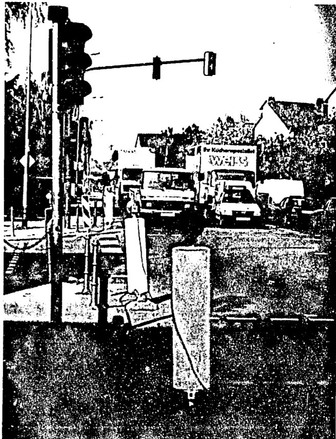
Lange Autoschlängen und schleppender Verkehr kennzeichnen zur Zeit des Bild auf der Südlichen Richtung. Grund dafür sind Bauarbeiten an den Salten. Vorgesammet auf die Zeit, wann diese wichtige Ost-West-Verbindung erst total umgestaltet wird und Verkehrsrisiko abnimmt.
