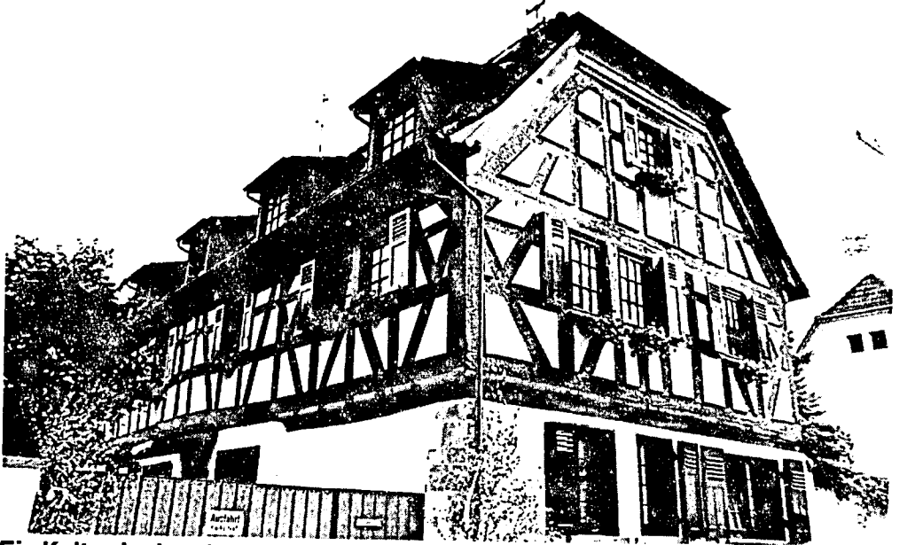
Ein Kulturdenkmal ist das Fachwerkhhaus an der Langener Straße 1. In der Denkmaltopographie des Kreises Offenbach wird es wie folgt beschrieben: „Großvolumiges Wohnhaus der zweiten Hälfte des 16. Jahrhunderts. Sockelgeschosß aus Bruchstein und Obergeschosß mit spätbarockem Fachwerk. Vor dem Bau der Synagoge an der Rheinstraße im Jahr 1903 war hier der Versammlungsort der jüdischen Gemeinde.“ Foto: hki
