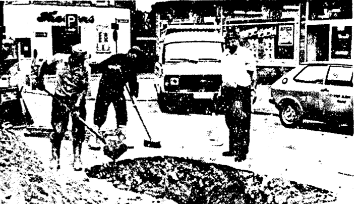
Mitarbeiter vom Tiefbauamt Langen bei der Reparatur des Kanals auf der Bahnstraße vor dem Postamt Langen.
