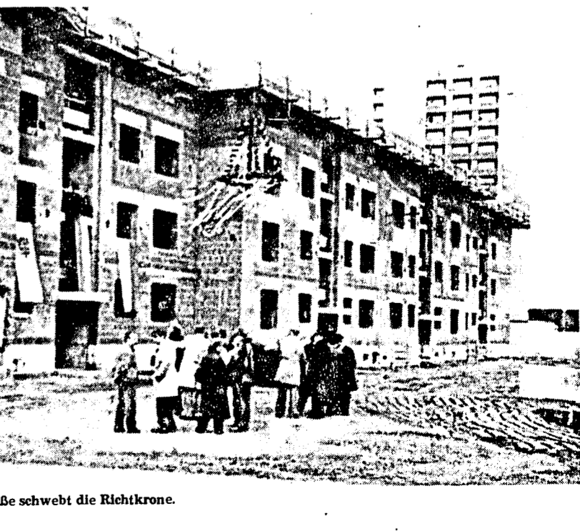
Über dem Neubau in der Annastraße schwebt die Richtkranne.
