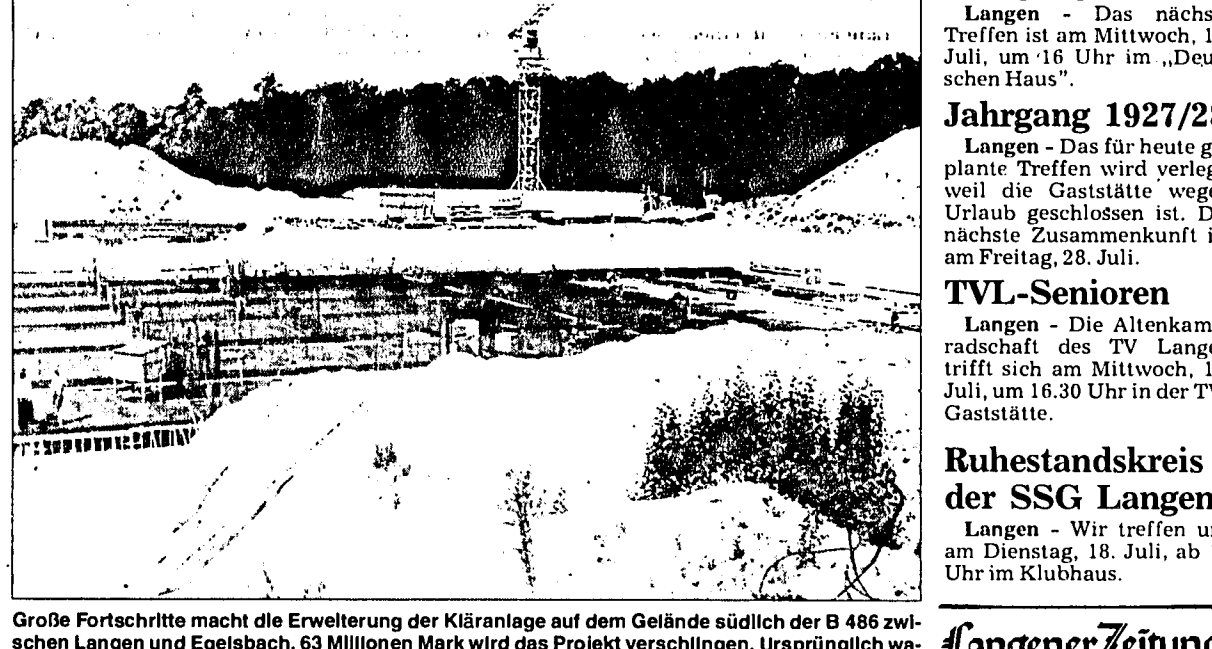
Große Fortschritte macht die Erweiterung der Kläranlage auf dem Gelände südlich der B 486 zwischen Langen und Egelsbach. 63 Millionen Mark wird das Projekt verschlingen. Ursprünglich waren 83 Millionen veranschlagt. Foto: Mahn
