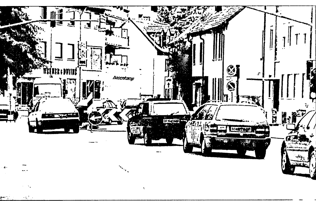
Wegen Kanalbauarbeiten ist derzeit die Frankfurter Straße in Höhe der Gabelsbergerstraße halbspaltig gesperrt. Die Arbeiten, die ursprünglich schon vor rund einem Monat beginnen sollten, werden nach Angaben der Stadtverwaltung bis Ende nächster Woche beendet sein. Nur wenige Meter entfernt, in der Fahrgasse, erwartet die Autofahrer ab Montag eine weitere Baustelle. Zwischen August-Bebel- und Rheinstraße wird eine neue Gasteltinger verlegt. Die Arbeiten sollen etwa acht Wochen dauern. Foto: Neels
