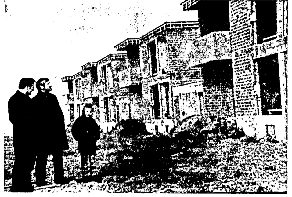
Im Wohngebiet Bayerseich sind einige Wohnungen bereits bezogen, andere stehen vor der Fertigstellung. Bürgermeister Dr. Simon benutzte einen Sonntagspaziergang mit seinem Sohn dazu, um sich von dem Fortschritt der Arbeiten ein Bild zu machen. Der Leiter des Bauamts, Gerd Niemuth, gab die erforderlichen Informationen. EN-Foto
