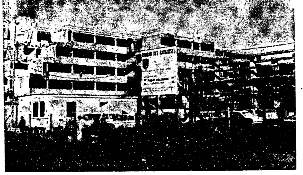
Der Rathausneubau macht Fortschritte. Noch in diesem Jahr sollen die Fenster dicht gemacht werden. L.Z.-Foto
