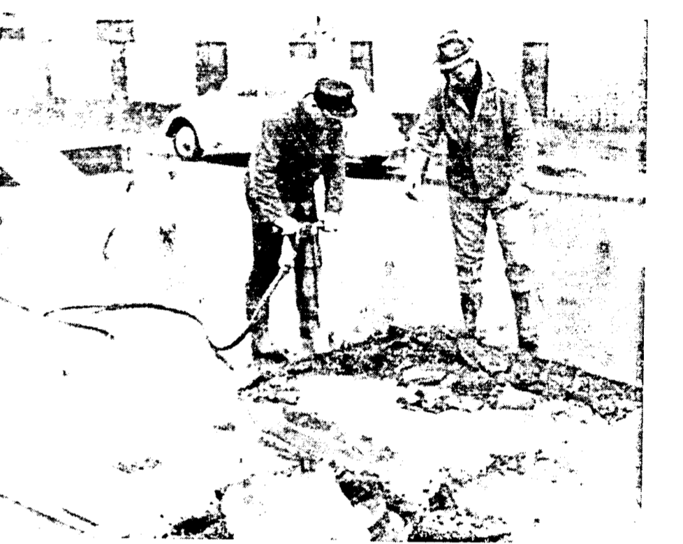
In der Gartenstraße mußte am Samstag ein Wasserrohrbruch behoben werden. Siehe auch den Bericht im Innern des Blattes. LZ-Bild
