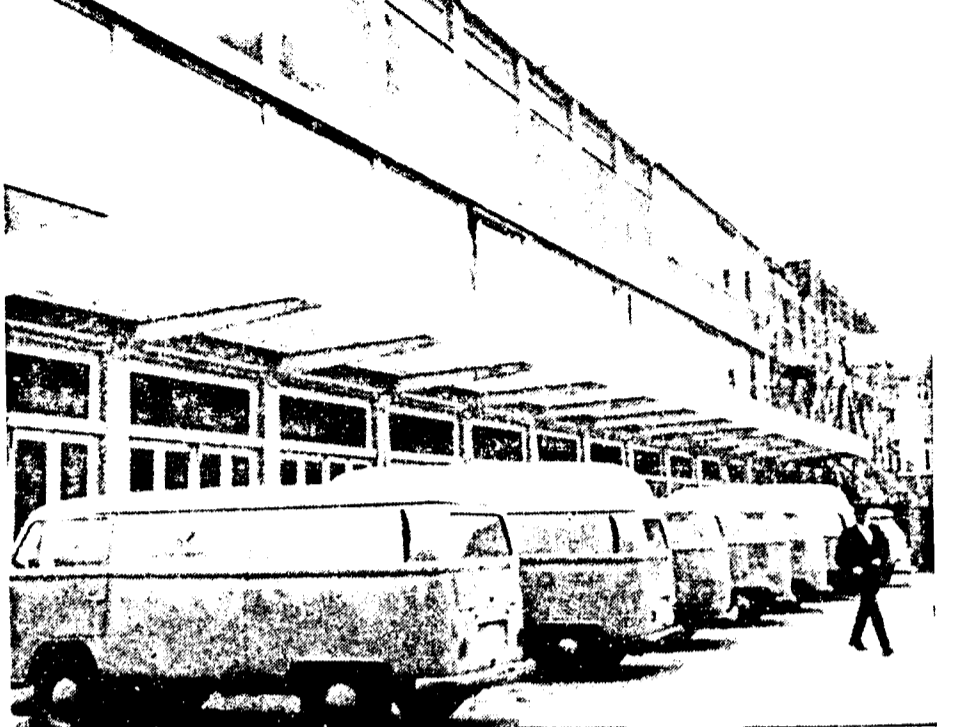
Das neue Gebäude des Postamtes Langen ist noch nicht vollständig fertiggestellt. Der Betrieb aber ist bereits in vollem Gange.
