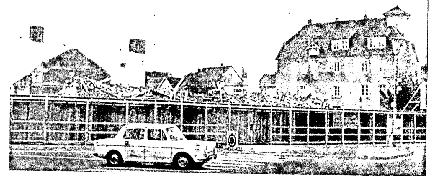
Ein ungewöhnliches Bild am Lutherplatz in Langen: der „Frankfurter Hof“ ist verschwunden. Hinter dem Bauzaun sind nur noch die Trümmer der Gebäude zu sehen. Bald wird hier ein moderner Neubau in die Höhe wachsen. 1/7-Bild
