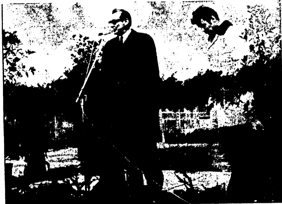
Der Geschäftsführer der Alpha-Bau, Dipl.-Volkswirt Gerhardt, bei seiner Rede zum ersten Spatenstich.
