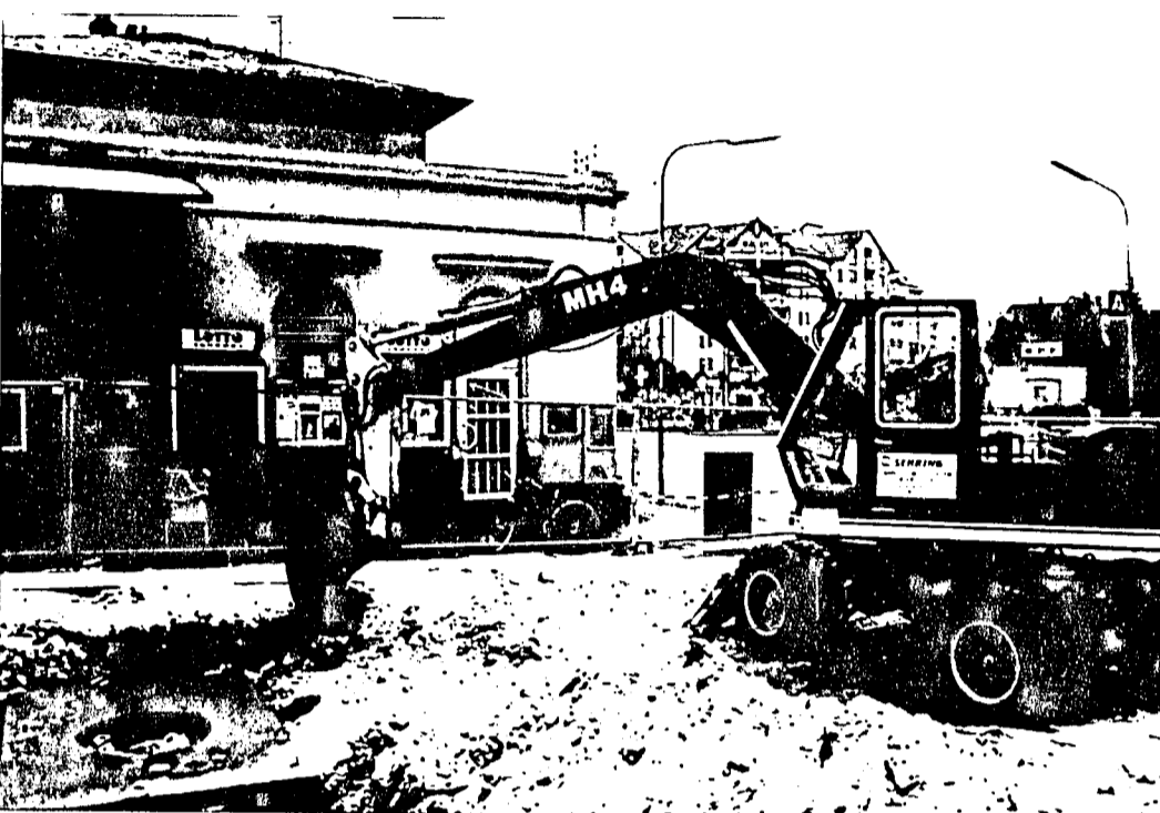
Spätestens bis Ende März, so versichert die Deutsche Bahn AG, soll die Baustelle neben dem Empfangsgebäude des Langener Bahnhofs endlich verschwunden sein. Weil sich die Aufstellung des neuen Toilettenhäuschens schon mehrfach verzögert hat, darf man gespannt sein, ob's tatsächlich so kommt. Foto: Borchard
