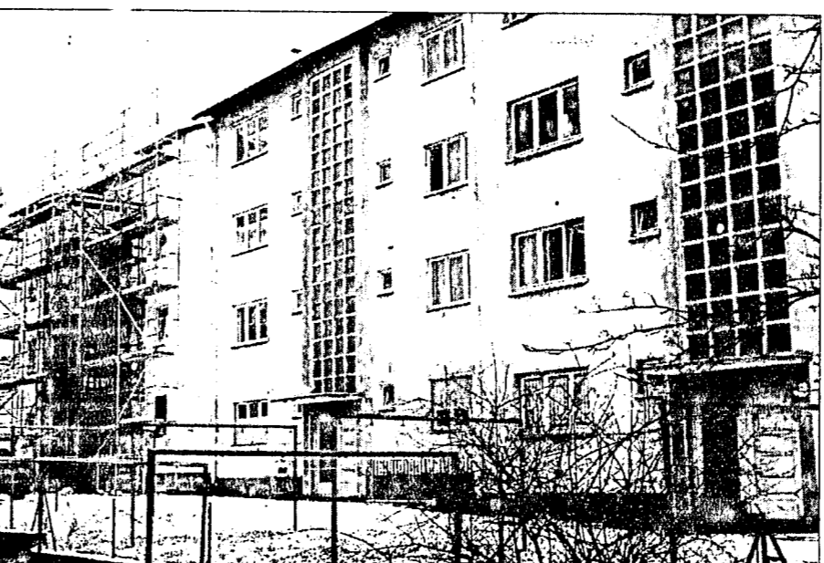
Der erste Bauabschnitt zur Sanierung der Sozialwohnungen in der Südlichen Ringstraße 162-166 ist bis auf den Außenanstrich fertig (hinten). Die 16 anderen Wohnungen des Blocks werden bis Ende kommenden Jahres umgebaut und saniert.
