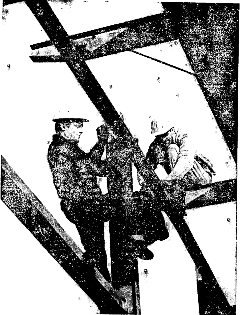
Auf dem Bau.
