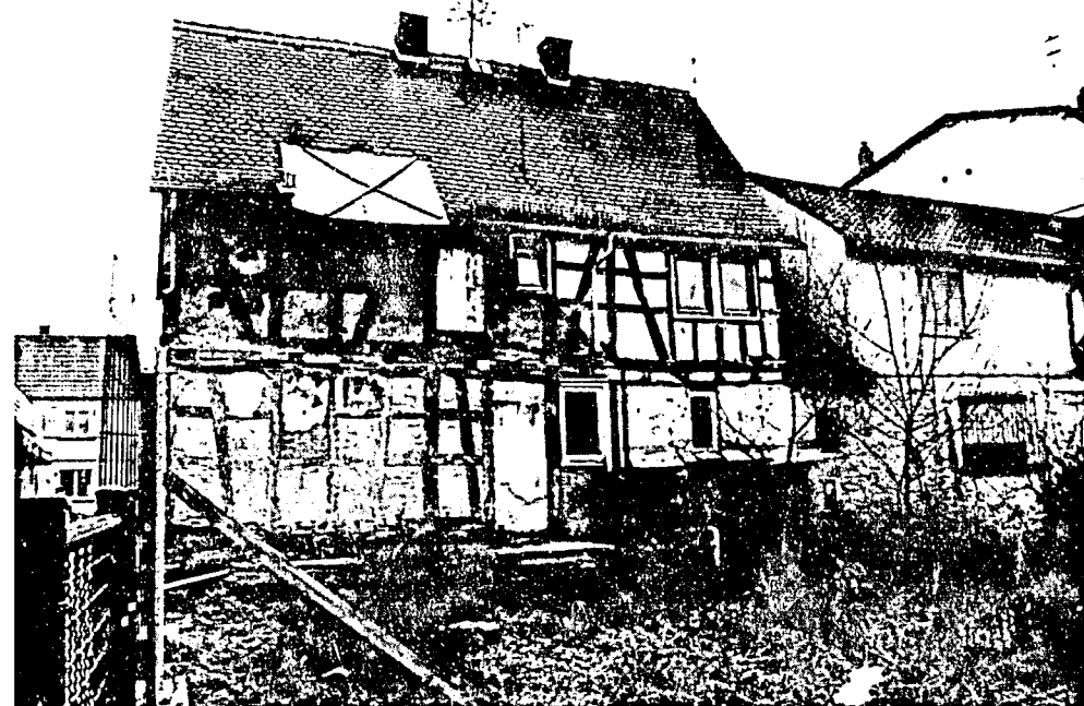
Ein freistehendes Bild bietet die Rückseite des Hauses Fahrgasse 28, die „Alte Schule“, die auch der Ausgangspunkt des heutigen Dreieich-Museums war. Ein geschichtsträchtiges Gebäude also, für dessen Renovierung und Umgestaltung zur Bücherei leider nicht genügend Geld in der Stadtkasse ist. Besser allerdings wird die Bausubstanz vom Stehlassen auch nicht.
