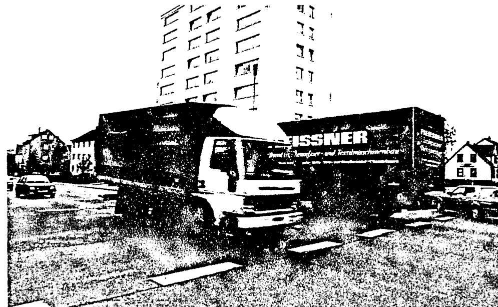
Vor allem die Brummis hatten in den vergangenen beiden Tagen ihre liebe Not, die vielbefahrene Kreuzung Südliche Ringstraße/Darmstädter Straße in westlicher beziehungsweise östlicher Richtung zu passieren. Wegen Umbauarbeiten an der Ampelanlage war die für einen längeren Zeitraum außer Betrieb. Zum Ärgernis von Autofahrern und Fußgängern wurde der Verkehr nicht während der gesamten Ausfallzeit von Polizeibeamten geregelt. Auf der Südlichen Ringstraße bildete sich stellenweise ein Rückstau bis zum Rathaus. Foto: sor
