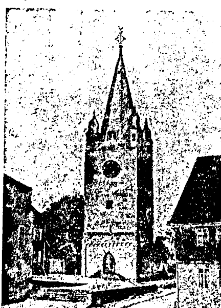
Der Turm der ehemaligen Jakobskirche
