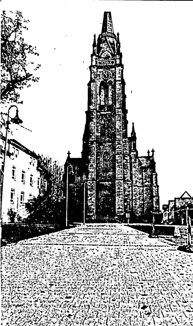
Der neue Weg zur Langener Stadtkirche ist nach Auffassung von Anliegern zu protzig geraten. Kritisiert wird insbesondere die Verwendung von Waschbeton-Pflaster. Foto: sor
