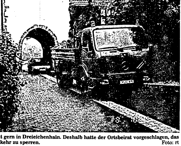
Bilder wie dieses sieht man nicht gern in Dreieichenhain. Deshalb hatte der Ortsbeirat vorgeschlagen, das Untertor für den Durchgangsverkehr zu sperren.
