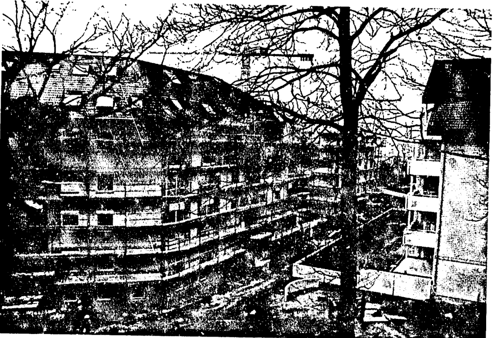
In der Wohnanlage Felsenkeller ist ein weiteres Gebäude gewachsen und im Rohbau fertig. Foto: rt
