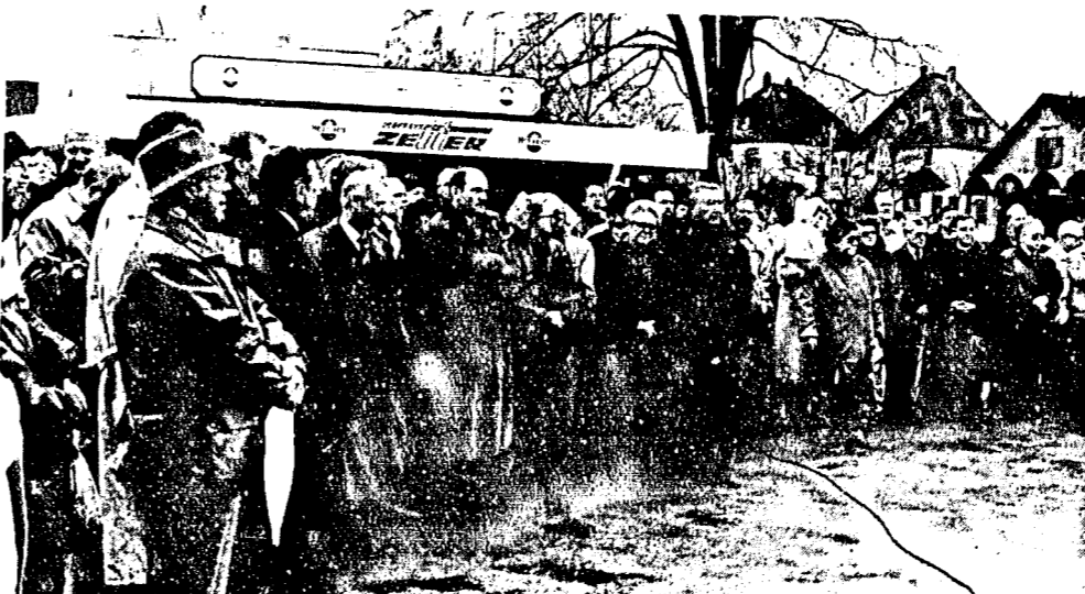
Viele Bürger versammelten sich am Montag auf dem Bahnhofsplatz, um das denkwürdige Ereignis des ersten Spatenstiches des S-Bahn-Beus mitzuerleben. Nach dem offiziellen Teil werteten Guleschuppe und Kühles Bier
