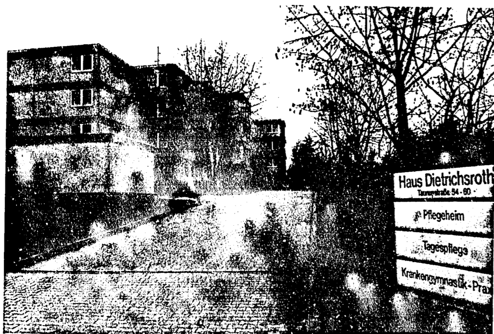
Das Haus Dietrichsroth bietet pflegebedürftigen Menschen eine umfassende Betreuung. Geplant ist, dem Komplex noch einen Anbau für „Betreutes Wohnen“ anzugliedern.
