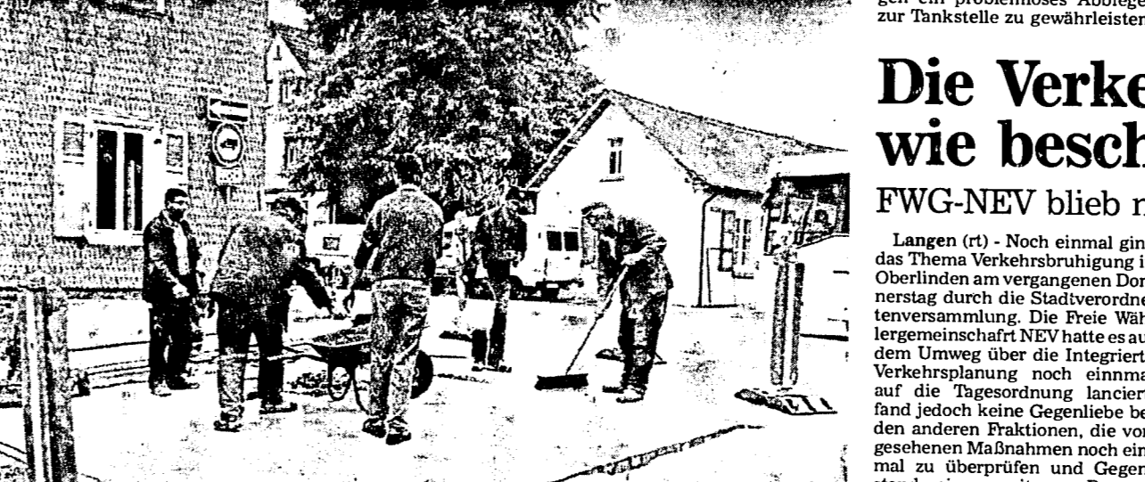
Bei der Einmündung der Wallstraße an der B 3 wurde jetzt eine Aufpflasterung vorgenommen. Durch das Rütteln des Fahrgeschäfts sollen die Kraftfahrer darauf aufmerksam gemacht werden, daß sie in eine Tempo-30-Zone eingetreten sind.
