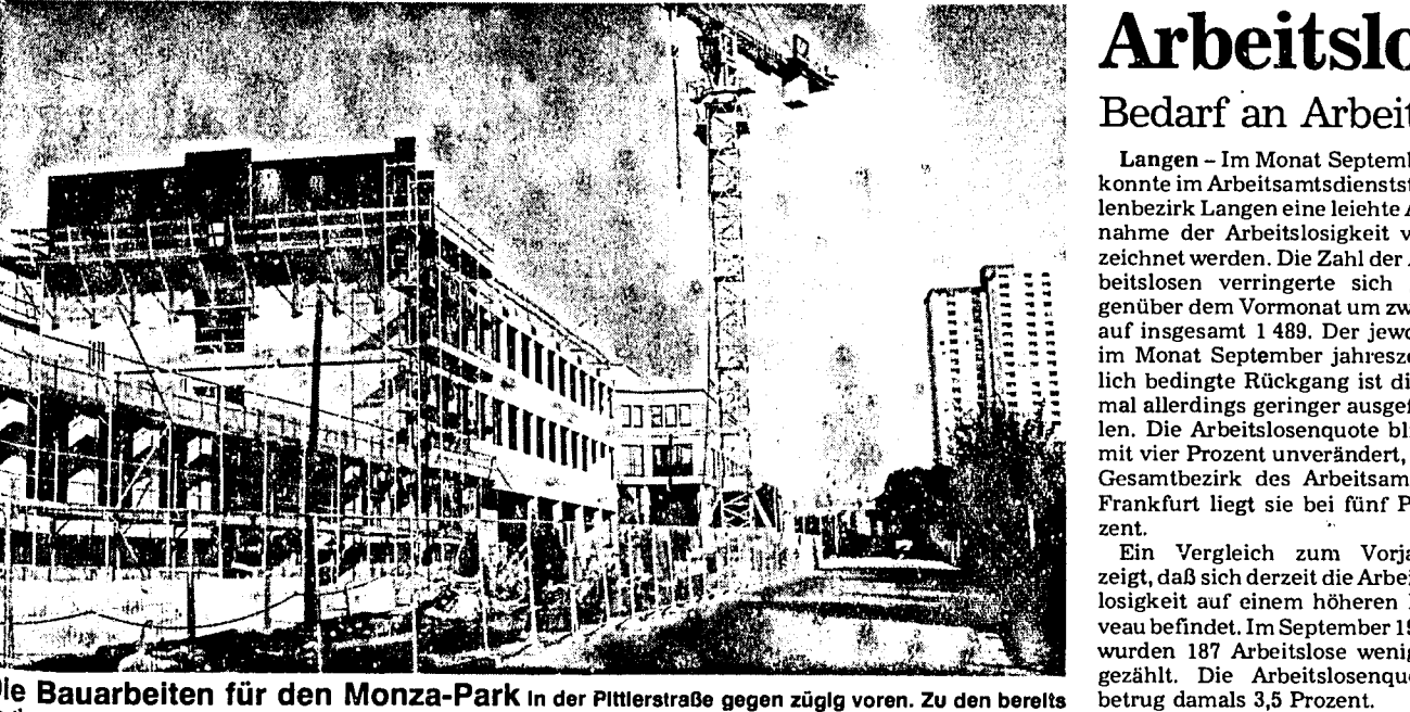
Die Bauarbeiten für den Monza-Park in der Pittlerstraße gegen zügig voren. Zu den bereits dort etablierten Unternehmen werden neue hinzukommen; es wird neue Arbeitsplätze geben.
