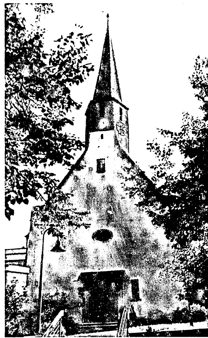
Renoviert werden soll im nächsten Frühjahr die Außenfassade der evangelischen Kirche. Einen entsprechenden Antrag hat die Kirche an die Gemeinde gestellt...
