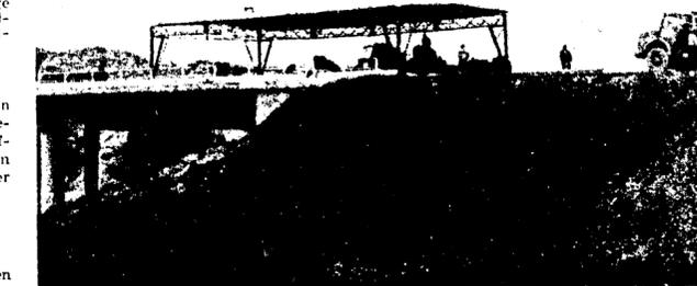
Die Autobahn östlich der Stadt erhält eine Asphaltdecke. Mit modernsten Straßenbau-maschinen wird gearbeitet. Ein transportables Dach über der jeweiligen Baustelle macht vom Wetter unabhängig. LZ-Foto
