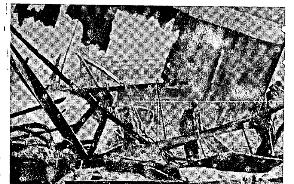
Ein Millionenschaden entstand in der Nacht, als in Köln die 150 m lange und 40 m breite völlig unterkellerte Halle eines Möbelgeschäftes aus bisher noch unbekannter Ursache niederbrannte. Unser spa-Bild zeigt einen Blick in die von Feuersbrunst zerstörte Lagerhalle, deren Stahlblech-Konstruktion in der Glut schwarz und einstrahlte. Sämtliche Möbel wurden ein Raub der Flammen, gegen die rund fünfzig Feuerwehrleute ankämpften.
