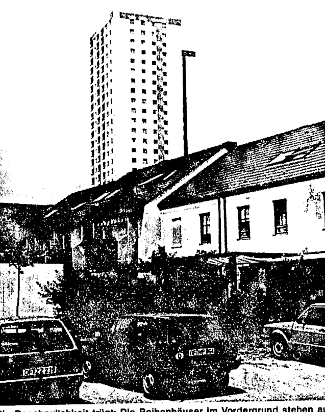
Die Beschaulichkeit trägt: Die Reihenhäuser im Vordergrund stehen auf brisantem Untergrund. Die Belastung mit Schwermetallen auf dem Areal an der Westendstraße ist derart hoch, daß der Boden ausgetauscht werden soll.
