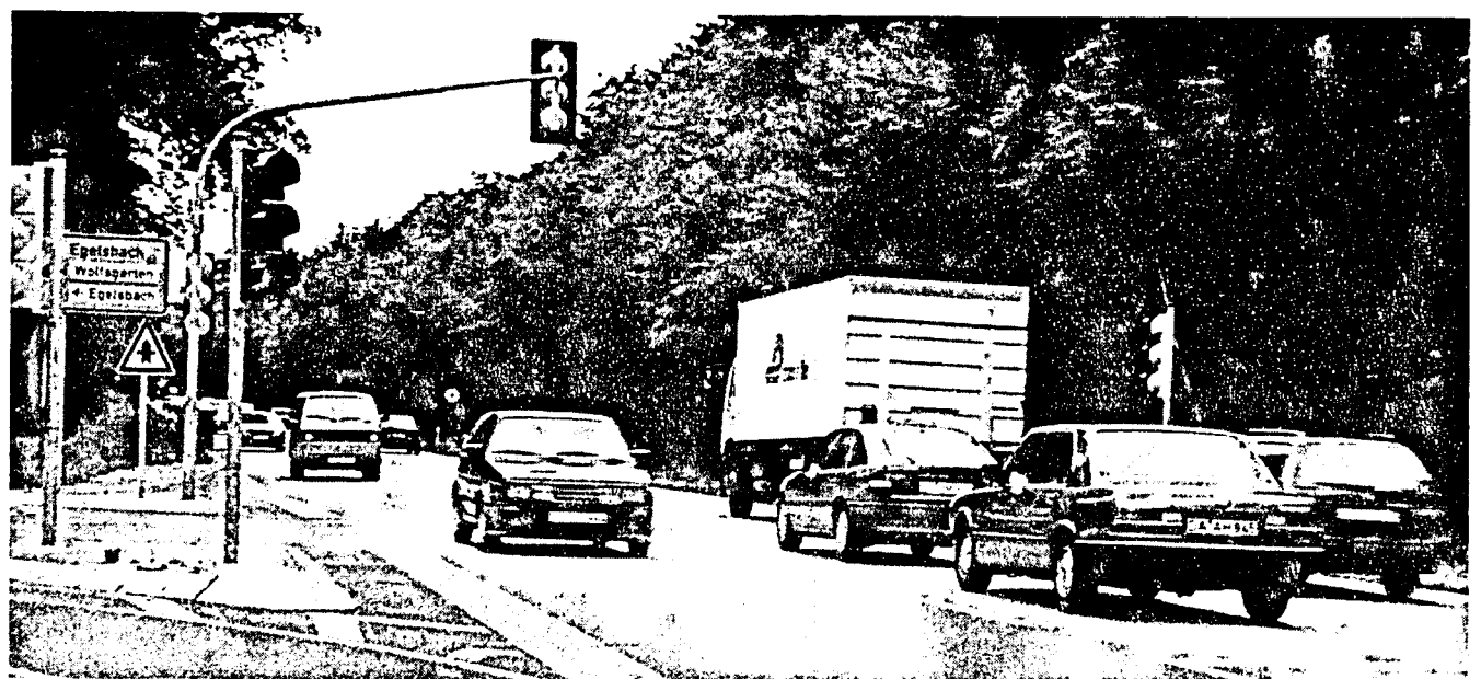
Von hier ab in westlicher Richtung soll die B 486 verbreitert werden. Zwei Bahnen zu je zwei Fahrspuren sind geplant. In der Mitte ist ein zwei Meter breiter Grünstreifen, an den Seiten sind Radwege vorgesehen. Foto: rt
