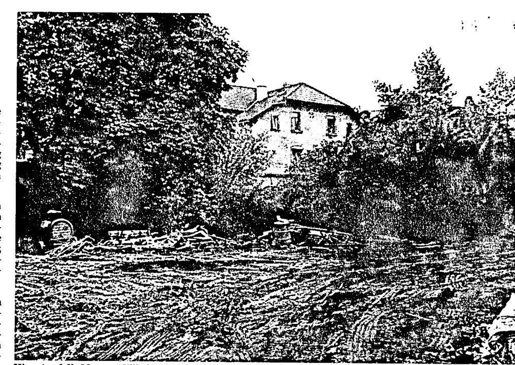
Hier stand die Metzger-Villa inmitten alter Bäume. Jetzt hat die Planierraupe ganze Arbeit geleistet.
