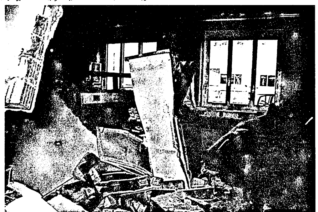
So sah es in dem Laborraum nach der Explosion aus. Alles ist zerstört und nicht mehr zu gebrauchen. Die Verzögerung wird einige Monate dauern.
