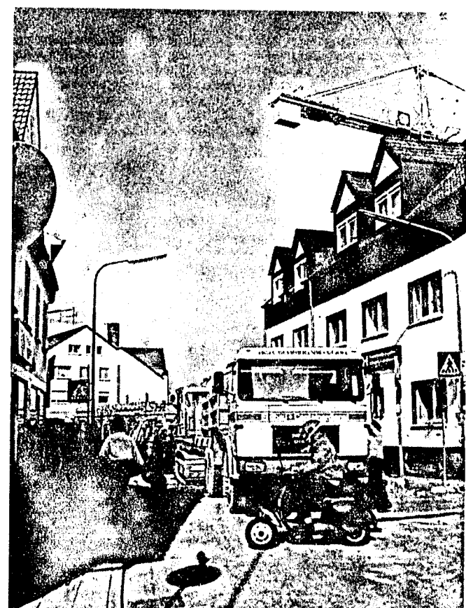
Die „Großbaustelle Rheinstraße“ bewegt sich mit ihren Kanalarbeiten langsam aber sicher in Richtung Wilhelmstraße. Die Wassergrube ist dadurch zur überquerenden Einbahnstraße geworden, eine Zufahrt des Wiegglöbchens von der Rheinstraße derzeit nicht mehr möglich.
