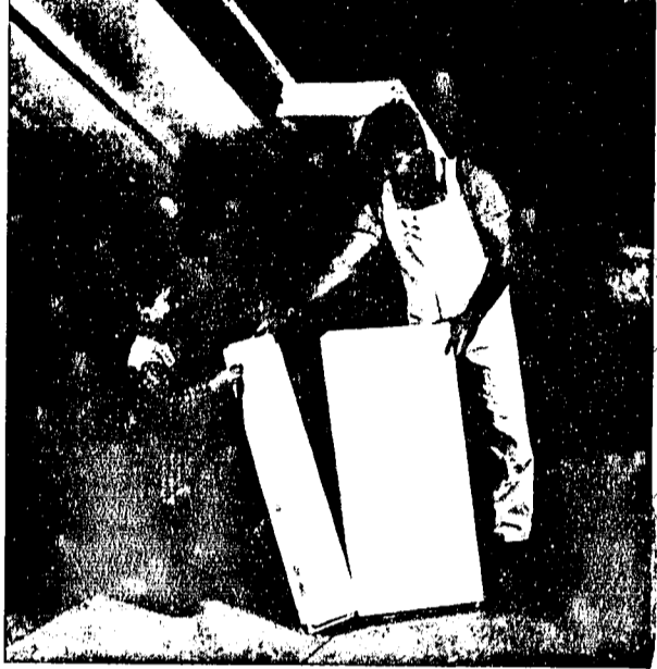
"Kinderleichte" Anwendung: Styrotect S-Platten werden ganz einfach zusammengesteckt, zugeschnitten und zwischen die Sparren geklemmt.
