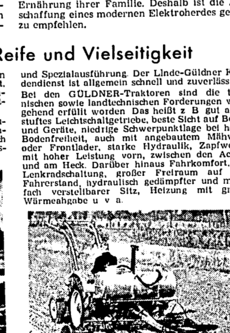
GÜLDNER G 30 mit Einzelkornrillgerät und Bandspritzeinrichtung
