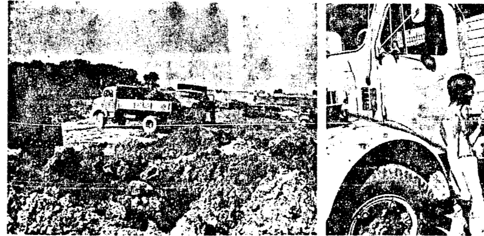
Diese Wüste mit den Brückenbauwerken im Hintergrund wird 1964 ein Teilstück der Autobahn Aachener Kreuz—Belgienlinie sein... Kraftwagen schaffen hier für Kraftwagen, Wilkonomie Transporte der „motorisierten Erdarbeiter“...
