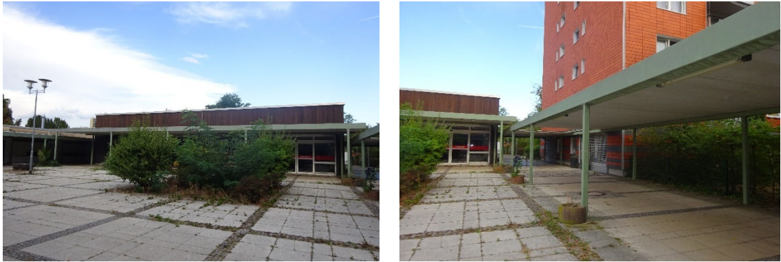
Abbildung 9: Blick in das Zentrum des baulichen Bestands (2)
