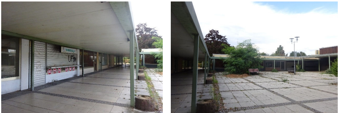
Abbildung 8: Blick in das Zentrum des baulichen Bestands (1)
