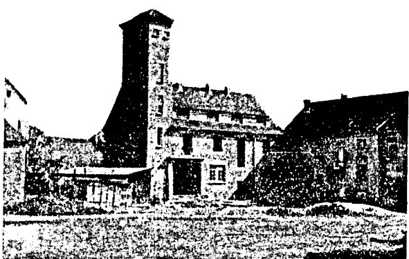
Das neue Feuerwehrgelände mit dem 17 Meter hohen Schlauchturm
