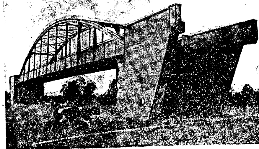
Diese Brücke wurde umsonst gebaut
