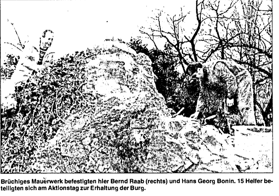
Brüchiges Mauerwerk befestigen hier Bernd Raab (rechts) und Hans Georg Bonin. 15 Helfer beteiligten sich am Aktionstag zur Erhaltung der Burg.
