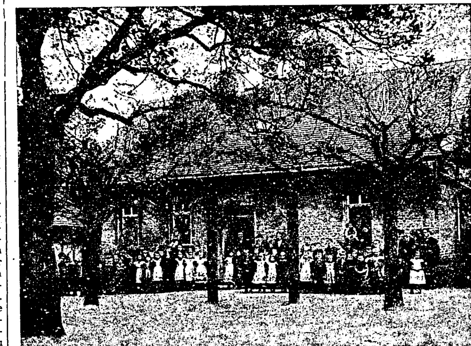
Vorderansicht der ehemaligen Höheren Bürgerschule, Dieburgerstraße
