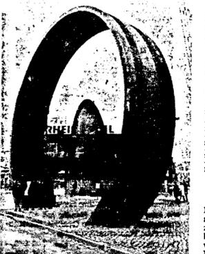
Für den neuen Hamburger Elbtunnel bestimmt ist dieser Tunntunnel aus duktilen Gußeisen. Er hat einen Außendurchmesser von 16,83 Metern und besteht aus 16 Einzelsegmenten.
