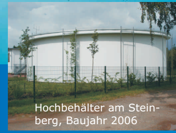
Wasserspeicher Wasserwerk West: Speichervolumen 5.000 m 3
