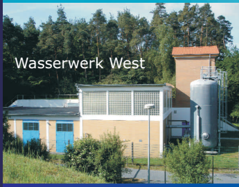
Wasserspeicher Wasserwerk West: Speichervolumen 5.000 m 3
